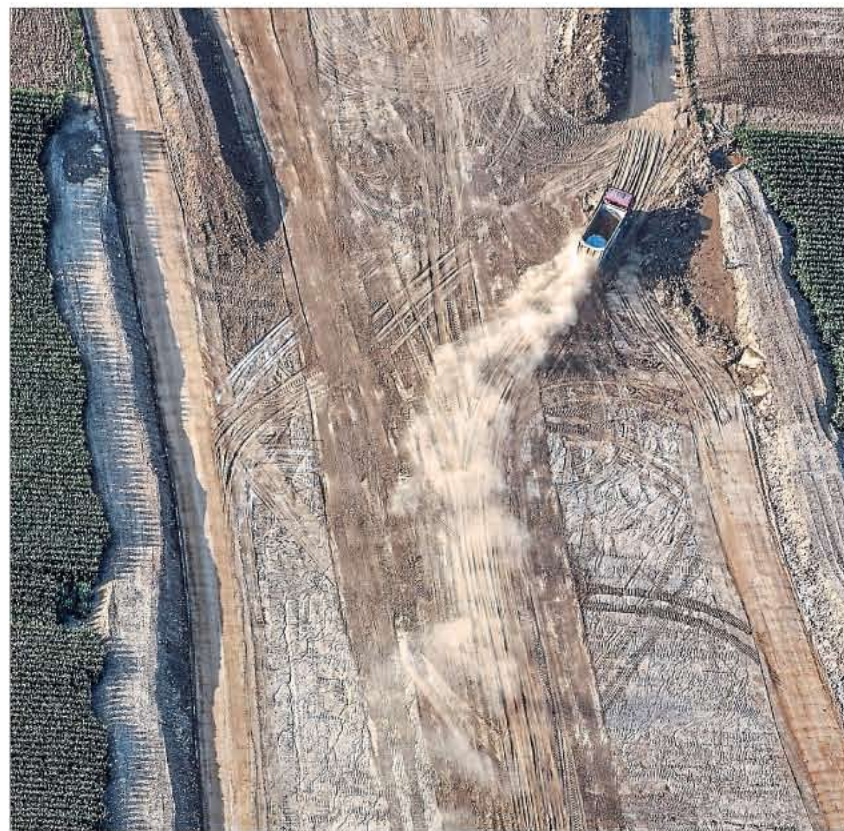
Die Trasse der B15neu wird durch die Landschaft gegraben: Bilder wie dieses sind den Projektgegnern ein Dorn im Auge. (Foto: Klaus Leidorf)
