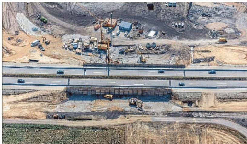
Bei Ohu entsteht bereits das umstrittene Autobahnkreuz zwischen der aus Richtung Regensburg kommenden B15 neu und der A92. (Foto: Leidorf)
