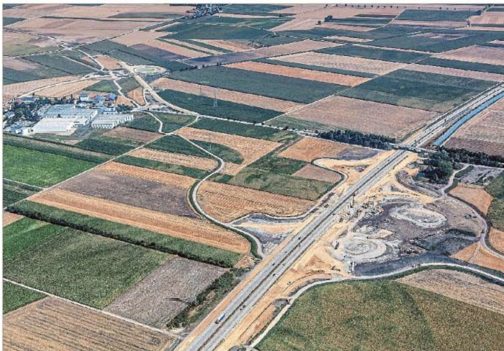
Die Arbeiten am künftigen Autobahnkreuz zwischen A92 und B15 neu bei Ohu laufen bereits.
