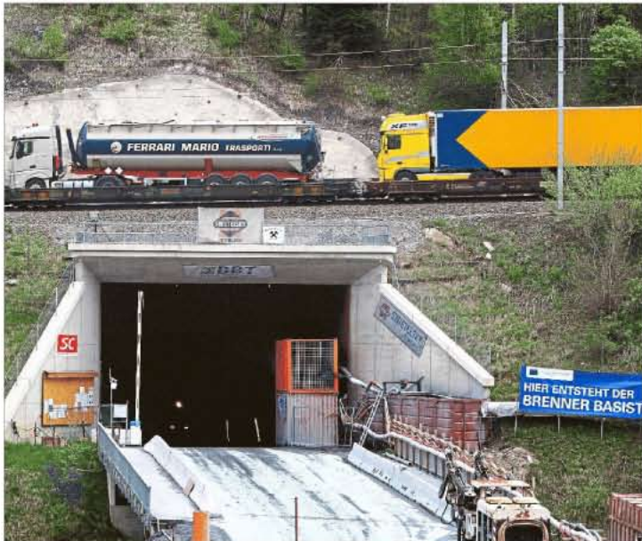
Die Arbeiten am Brennerbasistunnel (BBT) schreiten kontinuierlich voran. Bereits 2025 sollen die ersten Züge durch die Röhre rollen. Ein Teil des Zubringerverkehrs könnte nach dem Willen der Bahn über Landshut laufen. Foto: dpa
