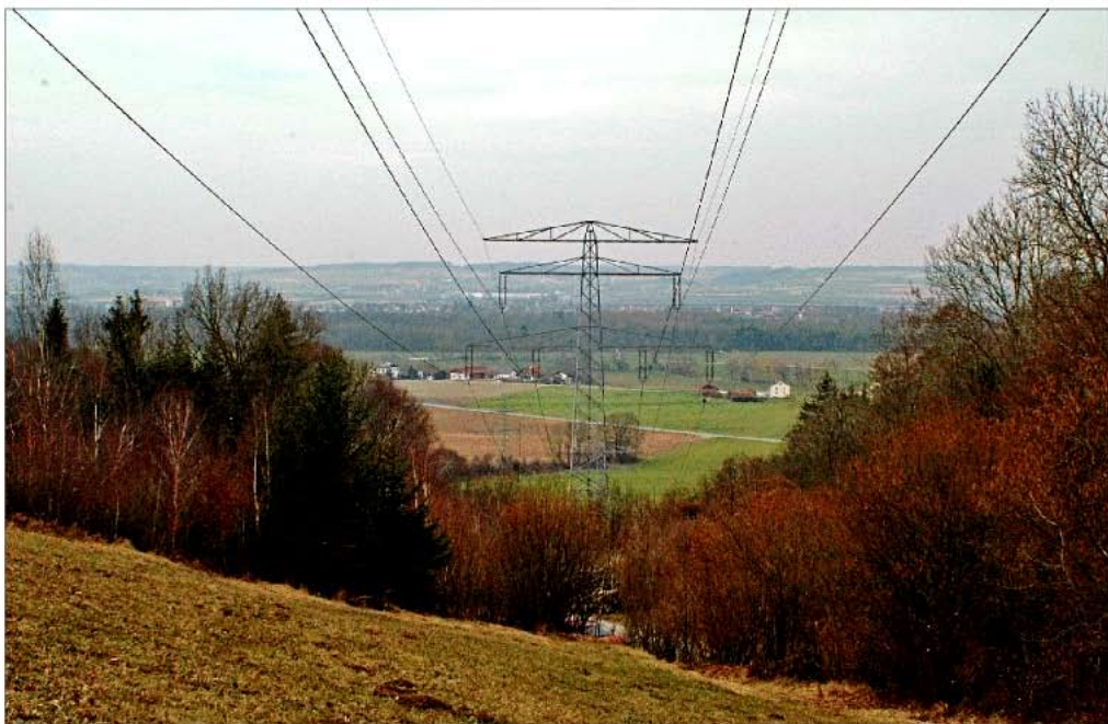
Blick von der Isarhangleite Richtung Nord-Westen: In etwa hier soll die Trasse der B15 neu verlaufen.
