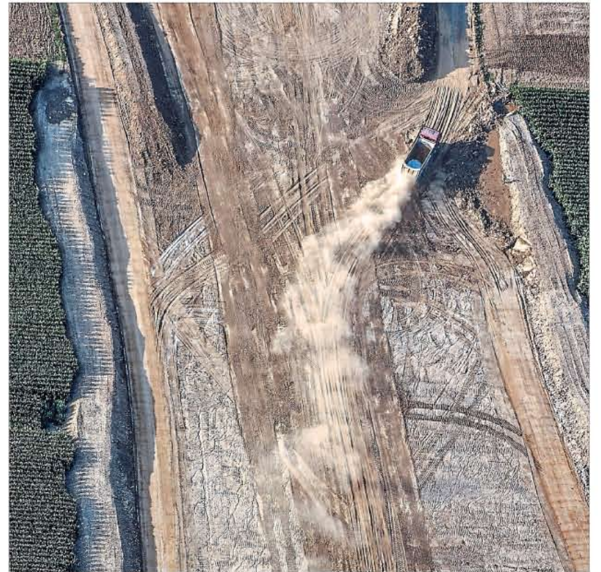
Die Trasse der B15neu wird durch die Landschaft gegraben: Bilder wie dieses sind den Projektgegnern ein Dorn im Auge. (Foto: Klaus Leidorf)
