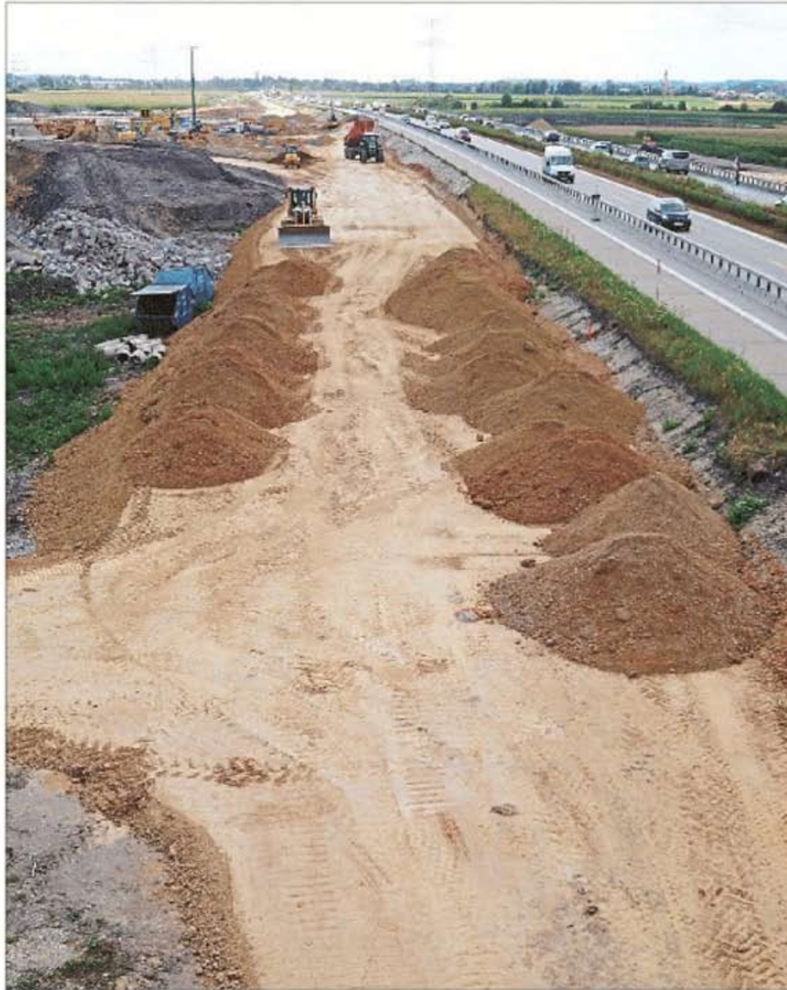
Die Bauarbeiten neben der A92 sind im Gang, die B15 neu kann kommen.
