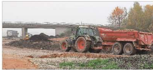
Unter anderem 16 Traktoren haben Tonnen von Erdmaterial bewegt.
