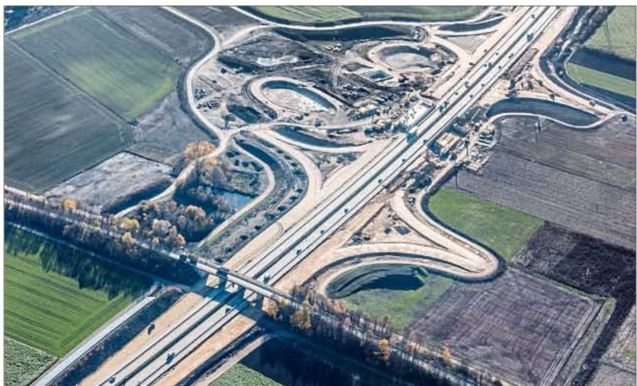
Bei Ohu laufen die Bauarbeiten am künftigen Autobahnkreuz der A92 mit der B15 neu. Sollte diese an Landshut vorbei Richtung Süden verlängert werden, würde die Stadt deutlich entlastet, sagt Prof. Dr. Harald Kurzak. Foto: Leidorf
