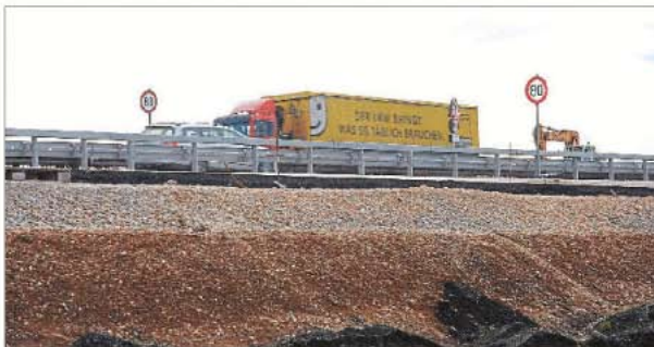
Das Tempolimit wird aus Sicherheitsgründen aufrecht erhalten, auch wenn in diesem Bereich der A92 aktuell nicht gebaut wird.
