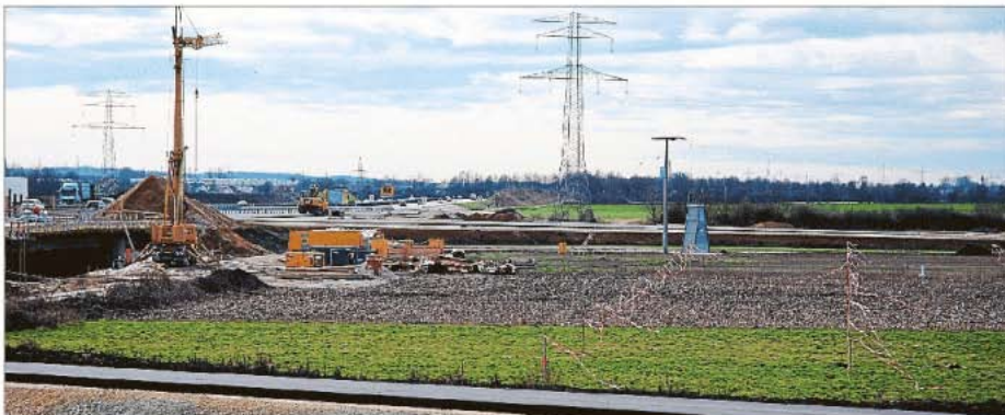
Auf den momentan brach liegenden Flächen neben der Baustelle flattern Absperrbänder. Diese sollen Wiesenbrüter davon abhalten, auf den Wiesen und Ackerflächen, die noch bebaut werden, zu brüten. (Fotos: Löw).
