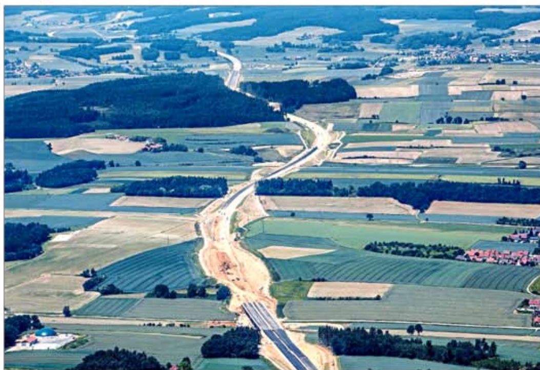
Ein Bild, das den Naturschützern weh tut: Die B15neu bahnt sich ihren Weg Richtung A92. Dort soll die vierspurige Straße nach dem Willen des BN aber enden. Foto: Klaus Leidorf
