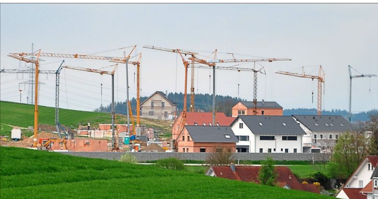
DER NABEL BAYERNs scheint Geisenhausen angesichts der vielen Kräne in Sachen Bautätigkeit zu sein. Bleibt zu hoffen, dass sich die Kräne nicht gegenseitig bei der Arbeit behindern. Foto: Josef Sirtl
