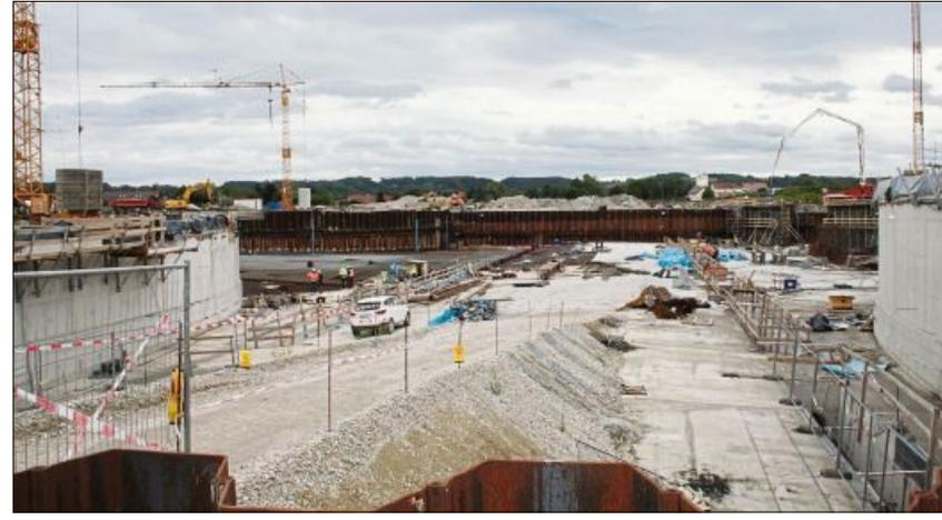
Für die Unterführung der B 15 neu unter der A 92 ist eine Grundwasserwanne nötig. Die Arbeiten für die Bodenplatte laufen. Die Fertigstellung des Abschnitts bis zur A 92 ist 2019 „angestrebt“, heißt es von der Autobahndirektion.
