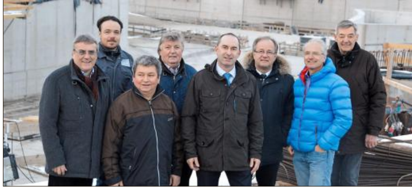
MdL Hubert Aiwanger und andere FW-Politiker besichtigten die Baustelle der Grundwasserwanne, deren Fertigstellung sich „erheblich“ verzögern wird.
